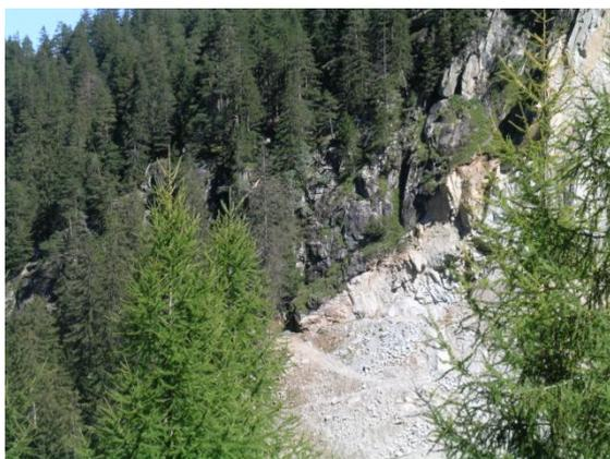
Bildstandort 15 Steinbruch Parsagna: Gestufte Räder als Endgestaltung nach dem Abbau
